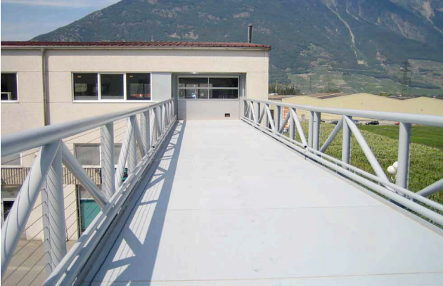
Objekt: Martigny; Brücke zwischen zwei Gebäuden
